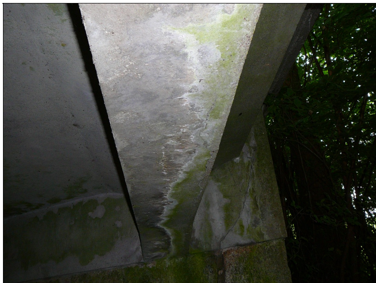
Podélné trhliny na krajním trámu NK
