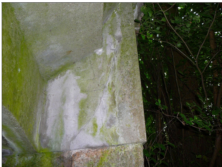
Trhliny na krajích koncových příčníků
