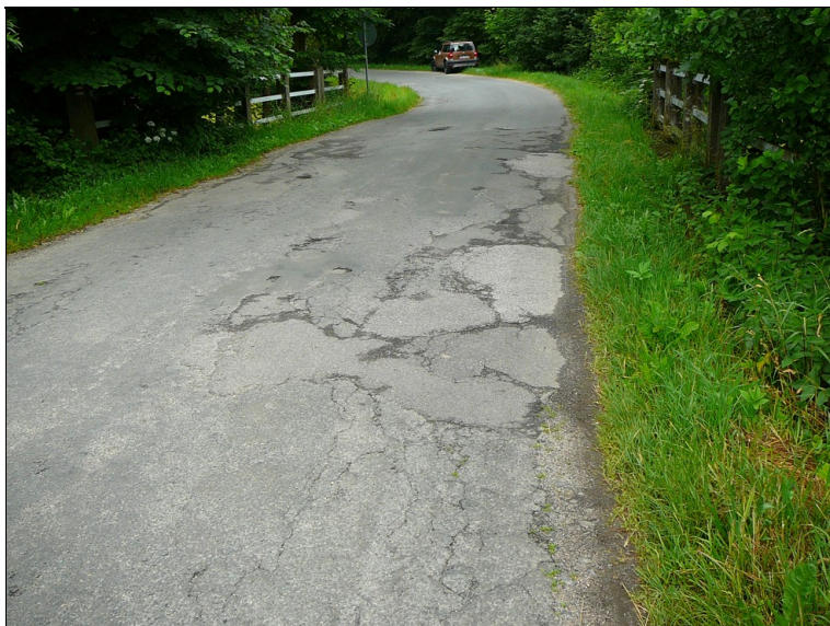
Trhliny a výtluky ve vozovce
