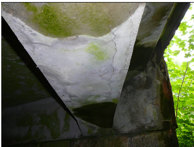
Trhliny a stopy po zatékání na krajní trám konstrukce.
