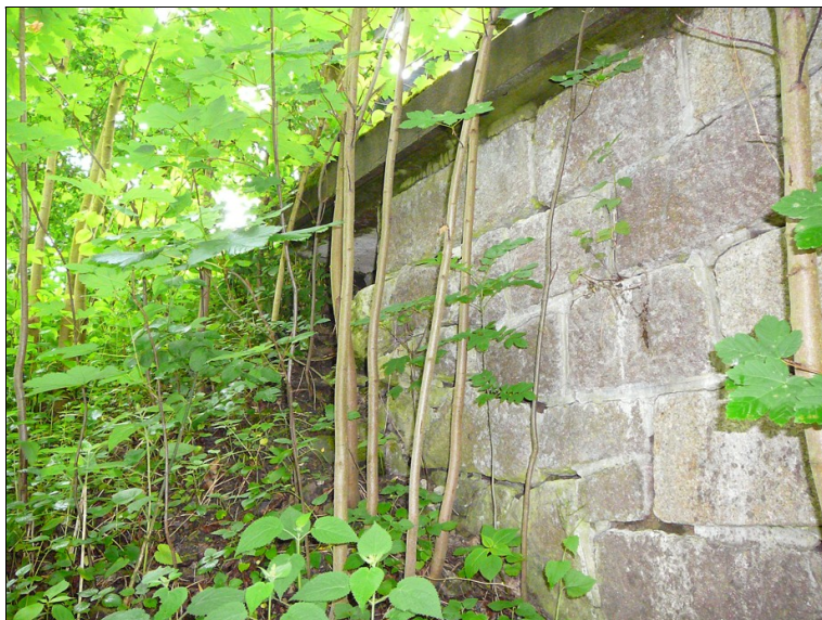
Rozpad křídla u OP1 vpravo
