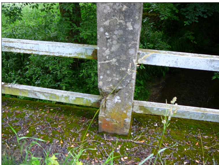
Trhliny v bet. sloupcích zábradlí
